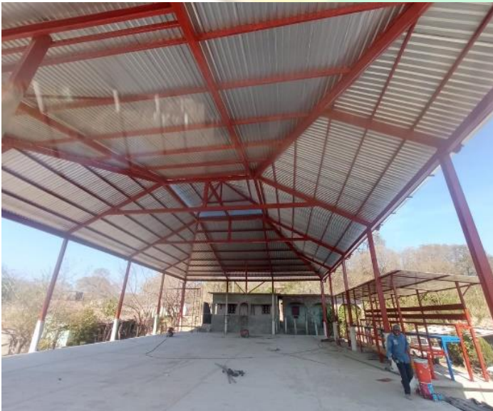
REHABILITACION DE CANCHA Y TECHADO EN ESPACIO MULTIDEPORTIVO EN LA LOCALIDAD DE CARABI GRANDE
