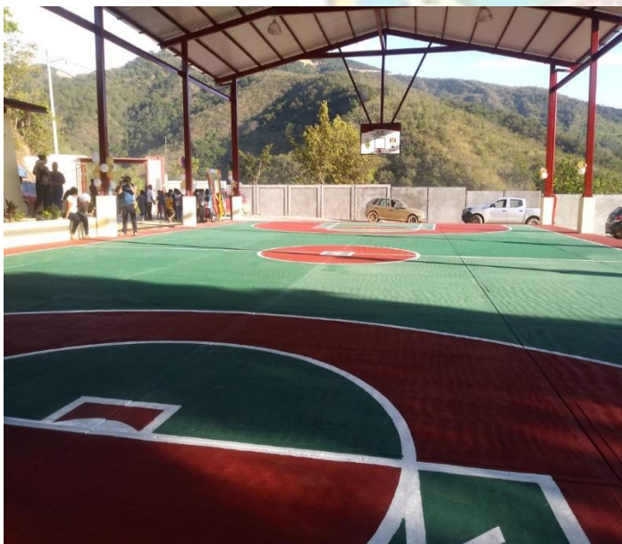
CONSTRUCCIÓN DE CANCHA Y TECHADO EN LA ESCUELA PRIMARIA DE LA LOCALIDAD DE CUADRILLA NUEVA
