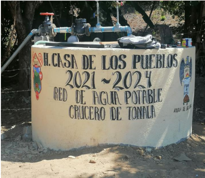
REHABILITACIÓN DE SISTEMA DE AGUA ENTUBADA EN EL CRUCERO DE TONALÁ
