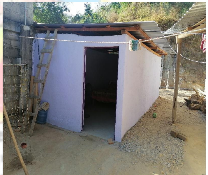
MEJORAMIENTO DE VIVIENDAS EN LA COLONIA LA LIBERTAD DE LA LOCALIDAD DE LA UNION
