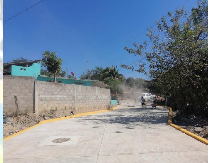
CONSTRUCCION DE PAVIMENTACION CON CONCRETO HIDRAULICO EN LA LOCALIDAD DE COLOTEPEC
