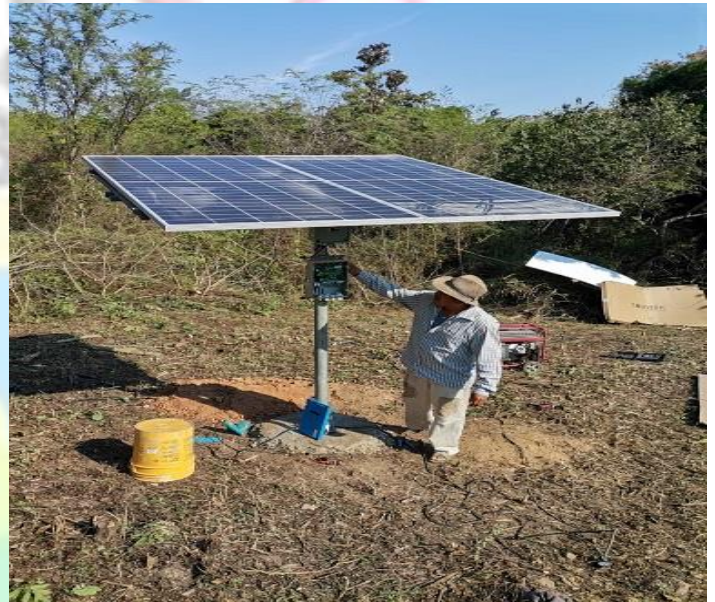
CONSTRUCCION DE CARCAMO DE BOMBEO DE AGUA POTABLE EN LA LOCALIDAD DE EL TEHUAJE
