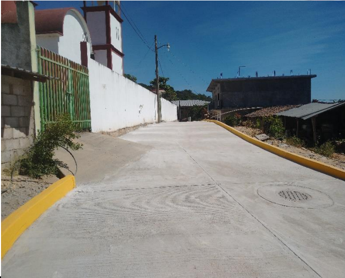
CONSTRUCCION DE PAVIMENTACION CON CONCRETO HIDRAULICO EN LA CALLE SAN ISIDRO LABRADOR, LOCALIDAD DE AHUACACHAHUE
